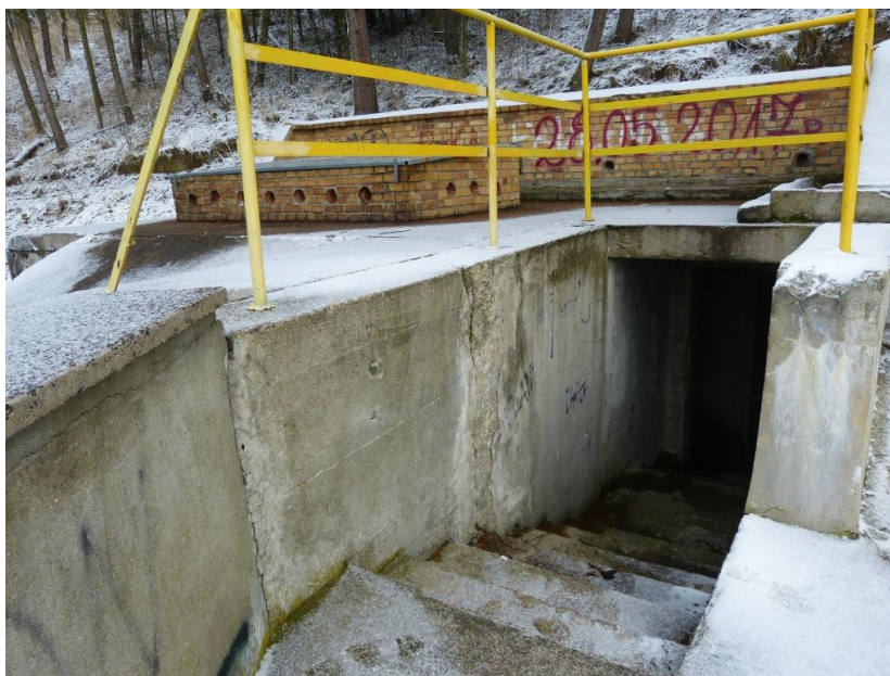
Fot.1. Wejście do galerii kontrolno-zastrzykowej
